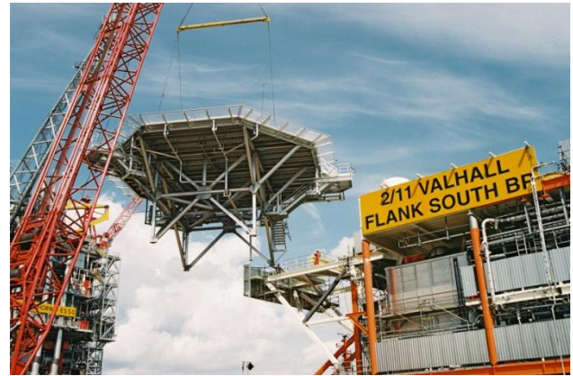
Figuur 15: helikopterdek van Bayards Aluminium Constructies BV
